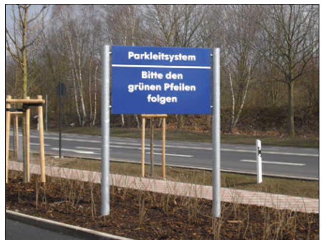
Hinweisschild 1.00 x 500 mm mit verzinkter Stahl-Unterkonstruktion
