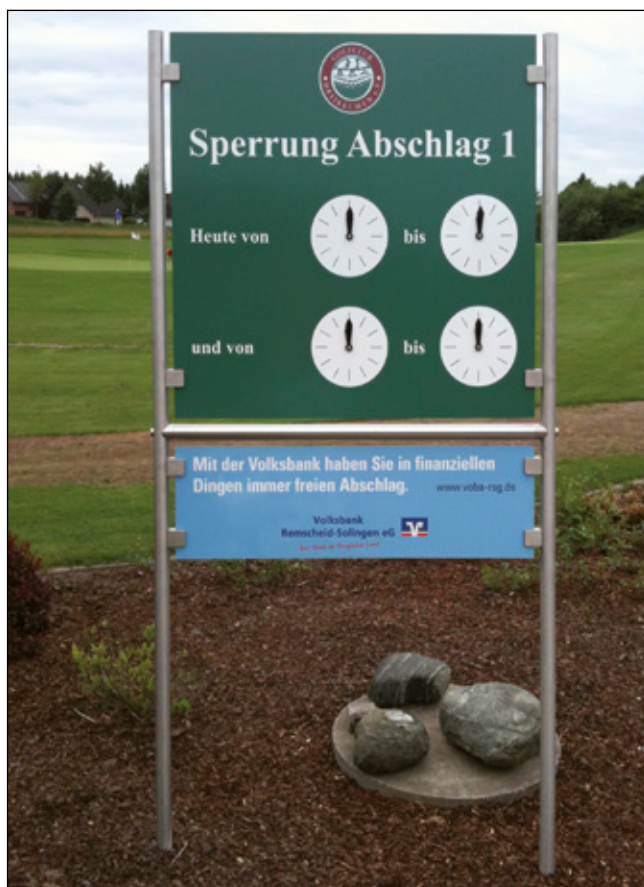
Hinweisschild (1.500 x 1.500 + 1.500 x 500 mm) mit Edelstahl-Standrohren
